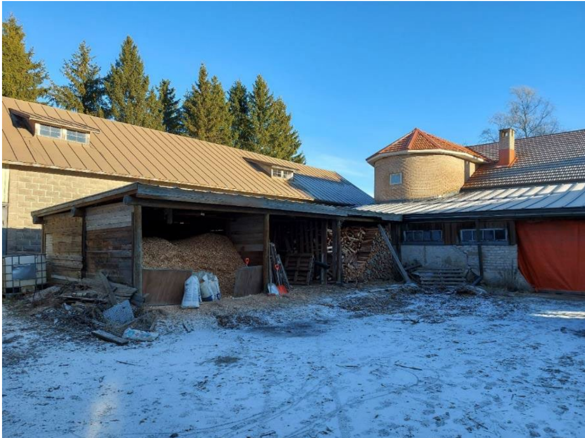
AIV-tornin katto kunnostettu.
