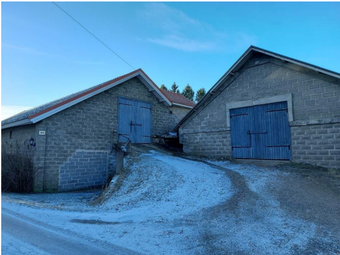
Navetta ja sikala on tehty profiloidusta sementtitiilestä.
