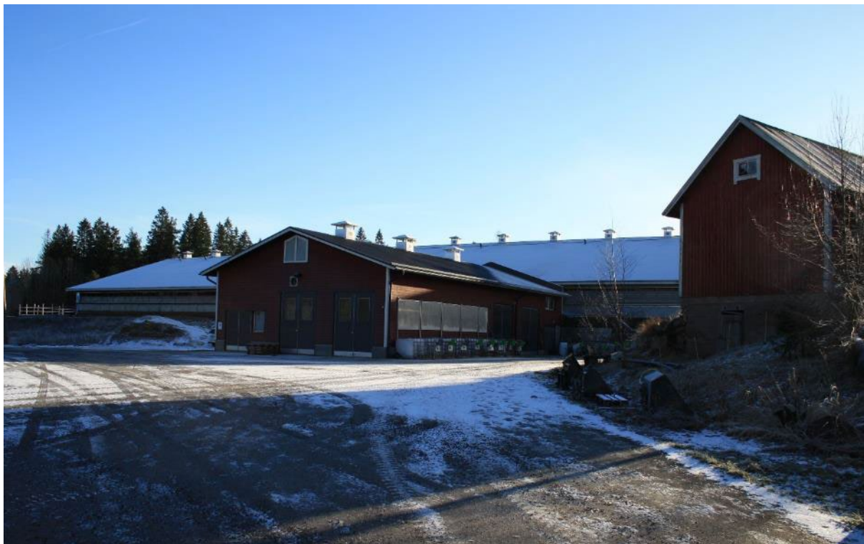
Uudet tuotantorakennukset ovat mittakaavaltaan huomattavasti suurempia kuin vanhat.
